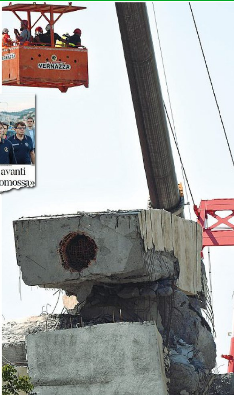
Monitoraggi Tecnici al lavoro per controllare i resti del ponte Morandi, crollato il 14 agosto a Genova (Ansa)
